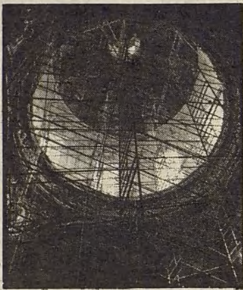
Un aspecto de la cúpula, en el interior de la capilla
